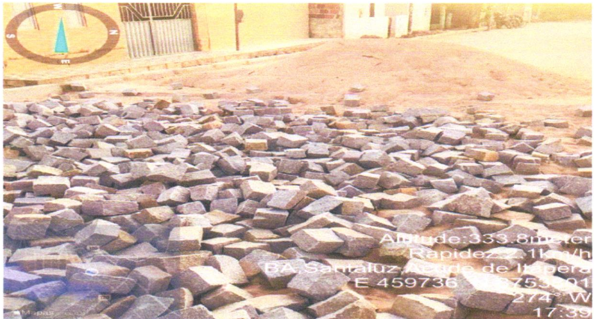
Execução de pavimentação Rua projetada 12
