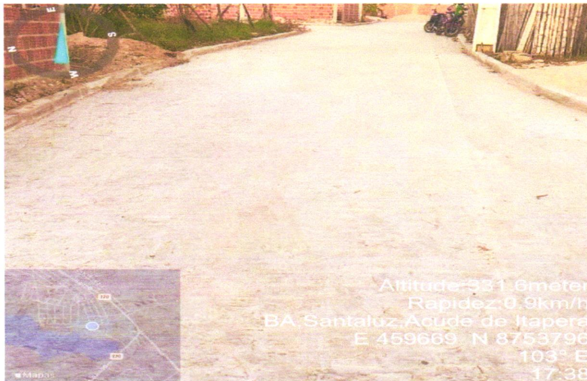
Execução de pavimentação Rua projetada 12
