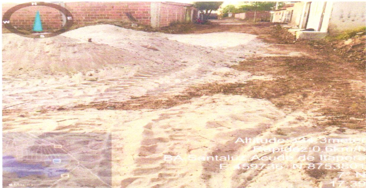
Execução de pavimentação Rua projetada 06
